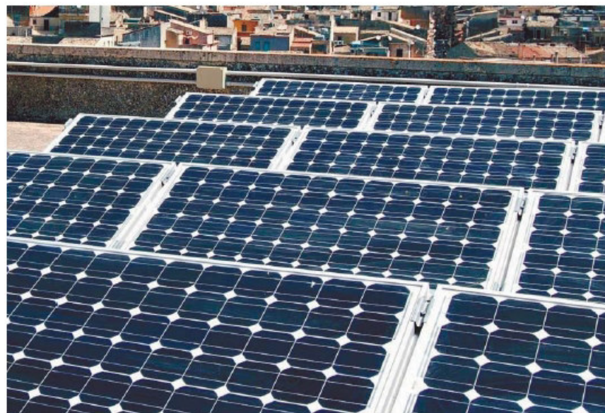
Legambiente apre alla possibilità di installare dei piccoli prati fotovoltaici su alcuni tetti del centro storico
