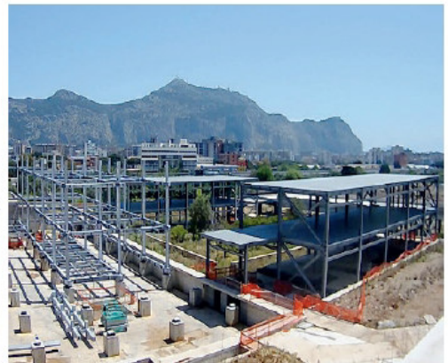
GLI SCHELETRI IN ACCIAIO DI QUELLO CHE SAREBBE DOVUTO ESSERE IL CHILDREN'S HOSPITAL
