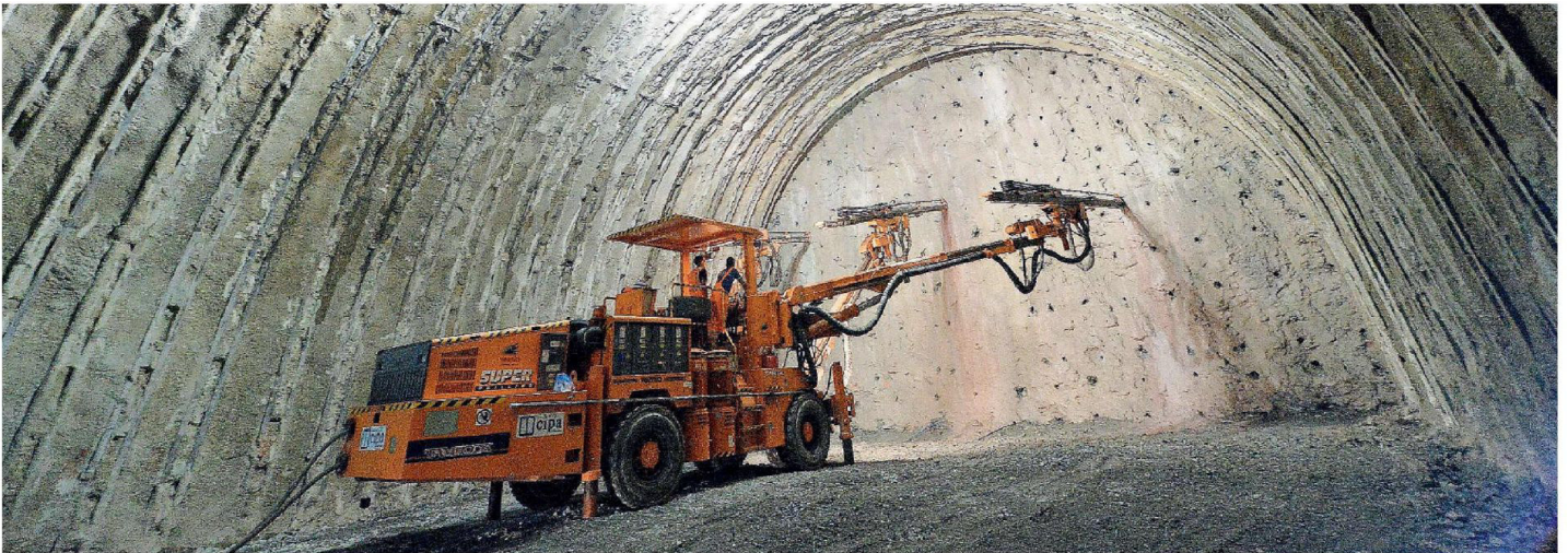
Renzi ha ammesso i difetti strutturali che penalizzano il Sud e ha assicurato investimenti sulle opere pubbliche
